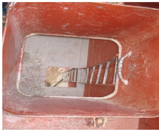
Фиг. 3. Изглед от входния люк към вертикалния трап
