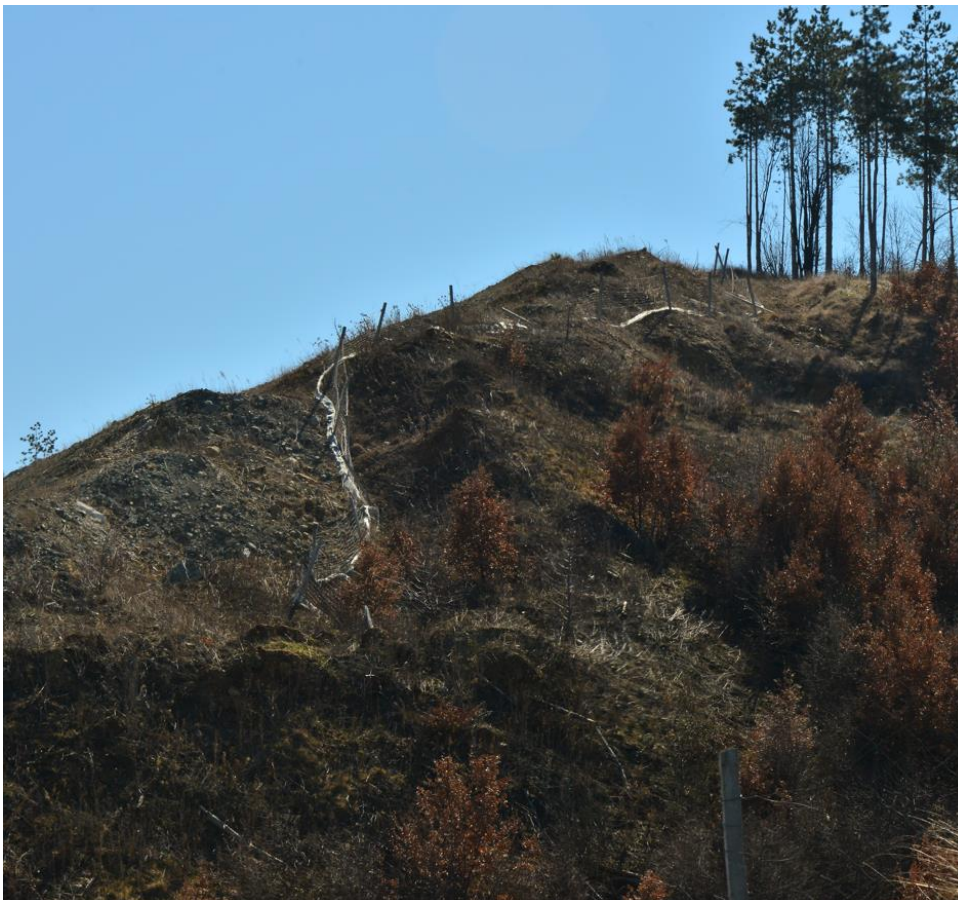
Снимков материал: Обход на Лот 3.1. Нефункционални предпазни огради
