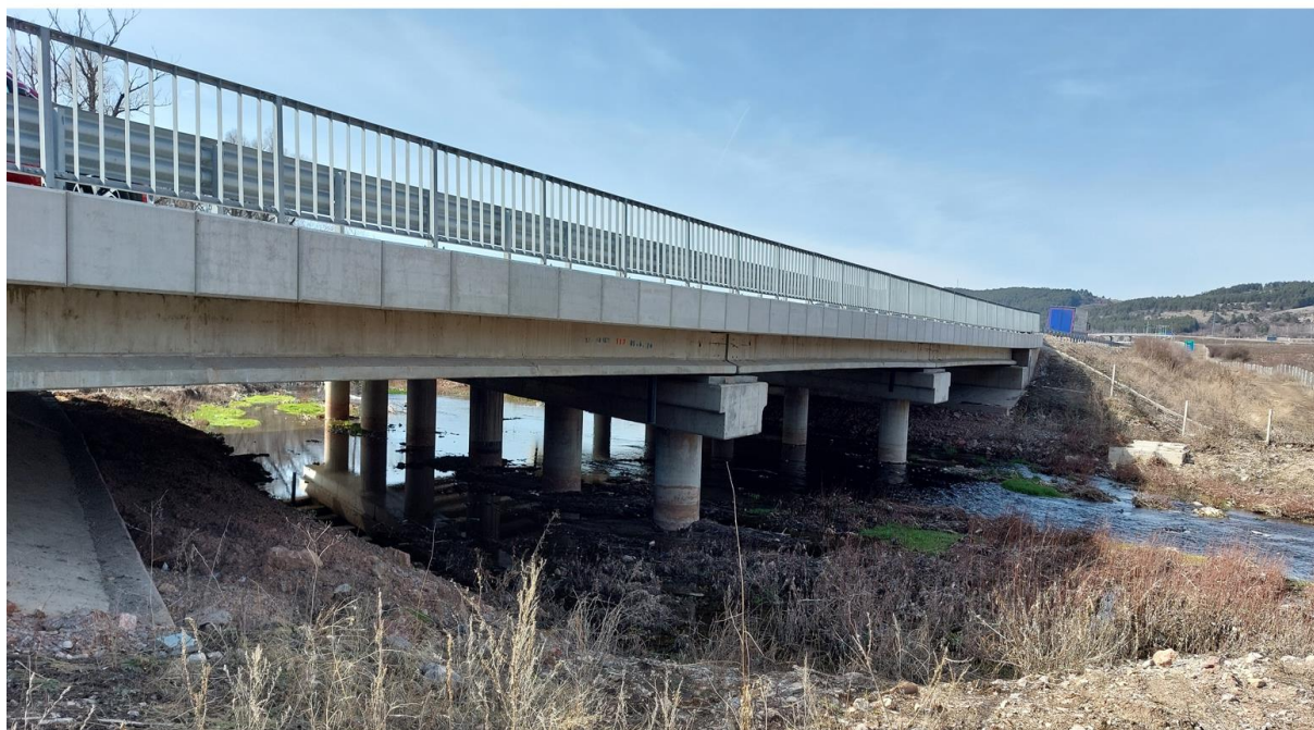
Снимков материал: Мостово съоръжение над р. Сливнишка
