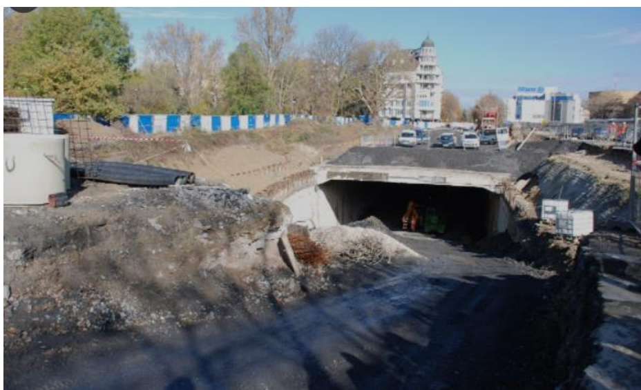
Снимков материал: Начало на строителството на метроучастък МС 5 (бул. Вл. Вазов) – МС 6 (Театър зад канала) от Етап 1 от проекта за изграждане на Линия 3 на метрото в София, архив 2017 г.
