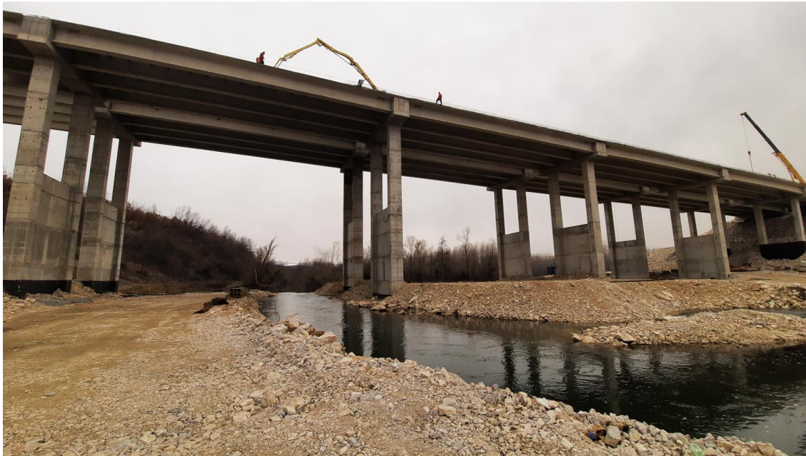
Снимков материал: Строеж на мост на р. Вита
