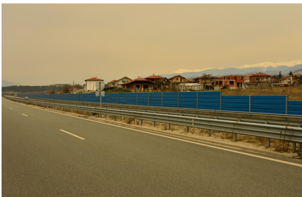
Снимков материал: Обход на Лот 3.3. Шумозащитни съоръжения
