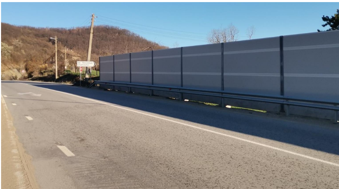
Снимков материал: Преградна стена при кв. Чехлевци
