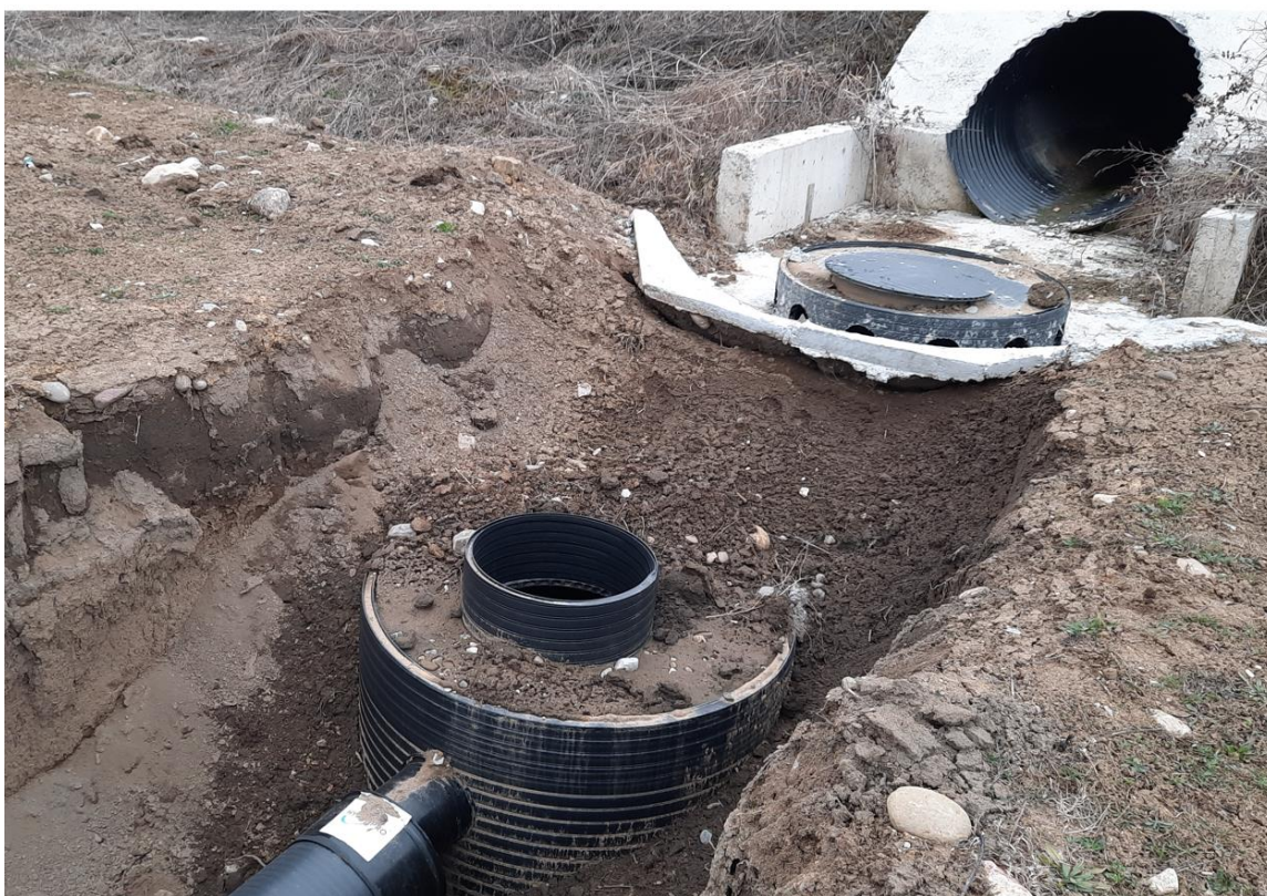
Снимков материал: Изграден каломаслоуловител в отсечката от км 80+220 до км 86+579
